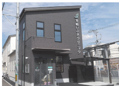
青崎いぶきクリニック外観
